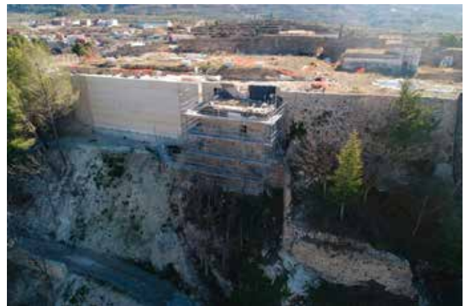
Figura 7: Vista aérea de los trabajos en la Torre Maestra del Castell de Planes. Área de Arquitectura - Archivo Gráfico MARQ.
