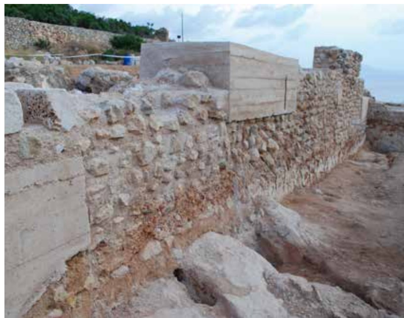
Figura 4: Trabajos de consolidación preventiva en la muralla norte. MARQ-Área de Arquitectura. Archivo Gráfico MARQ.
