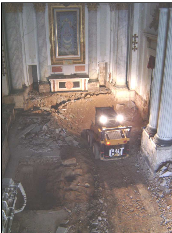
Vista de la excavación de la capella.
