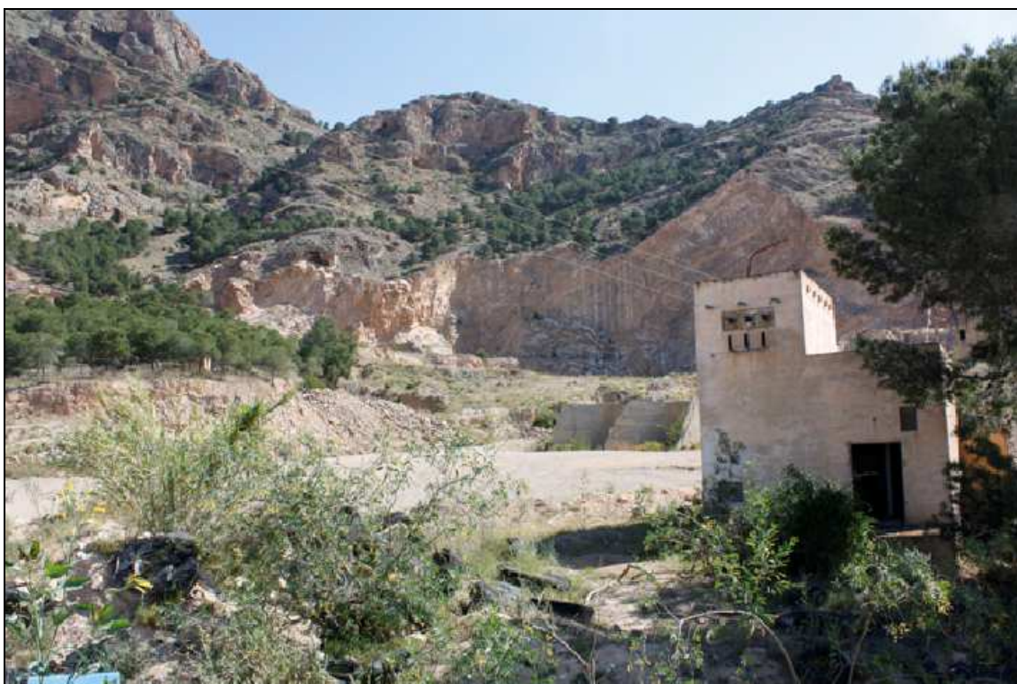
Vista del área de actuación, con la cantera de extracción en la sierra.
