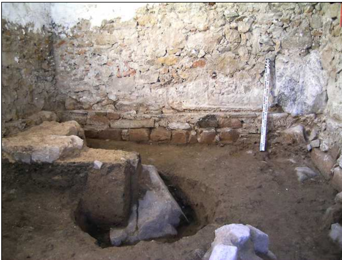
Vista del alzado norte con sillares en la base.
