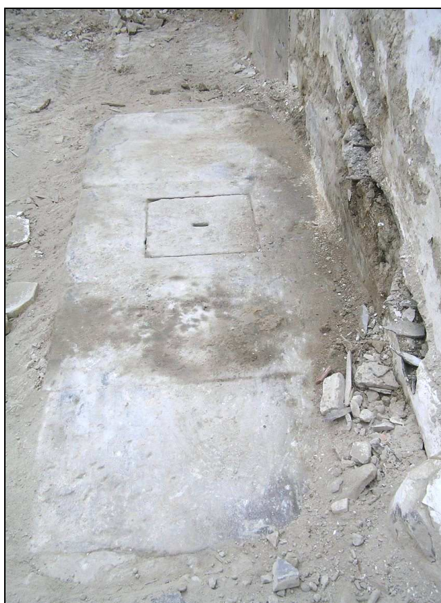
Vista de la cisterna "cuba" UE 3.
