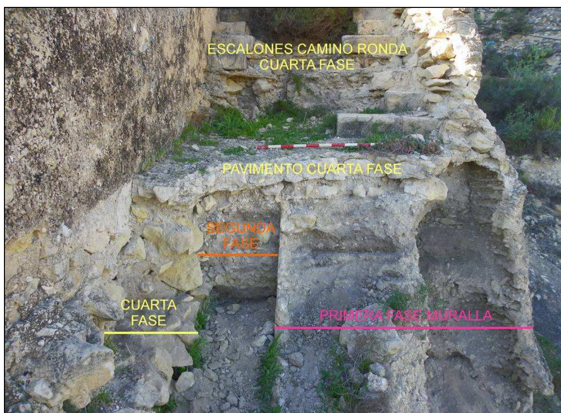
Distintas fases constructivas documentadas en el lienzo de la muralla.
