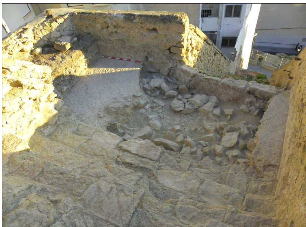
Vista final del pequeño sondeo junto a la torre bajomedieval, en el paseo de ronda.
