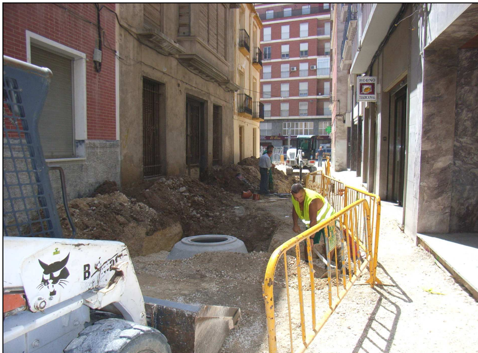
Vista parcial de la intervención en la calle Solars.
