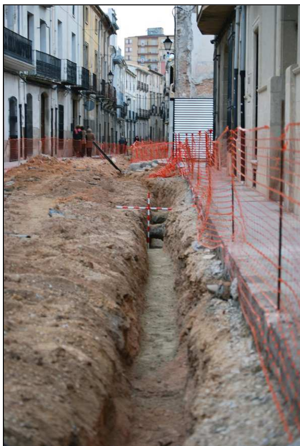
Detalle de la zanja de gas abierta en el carrer Major.
