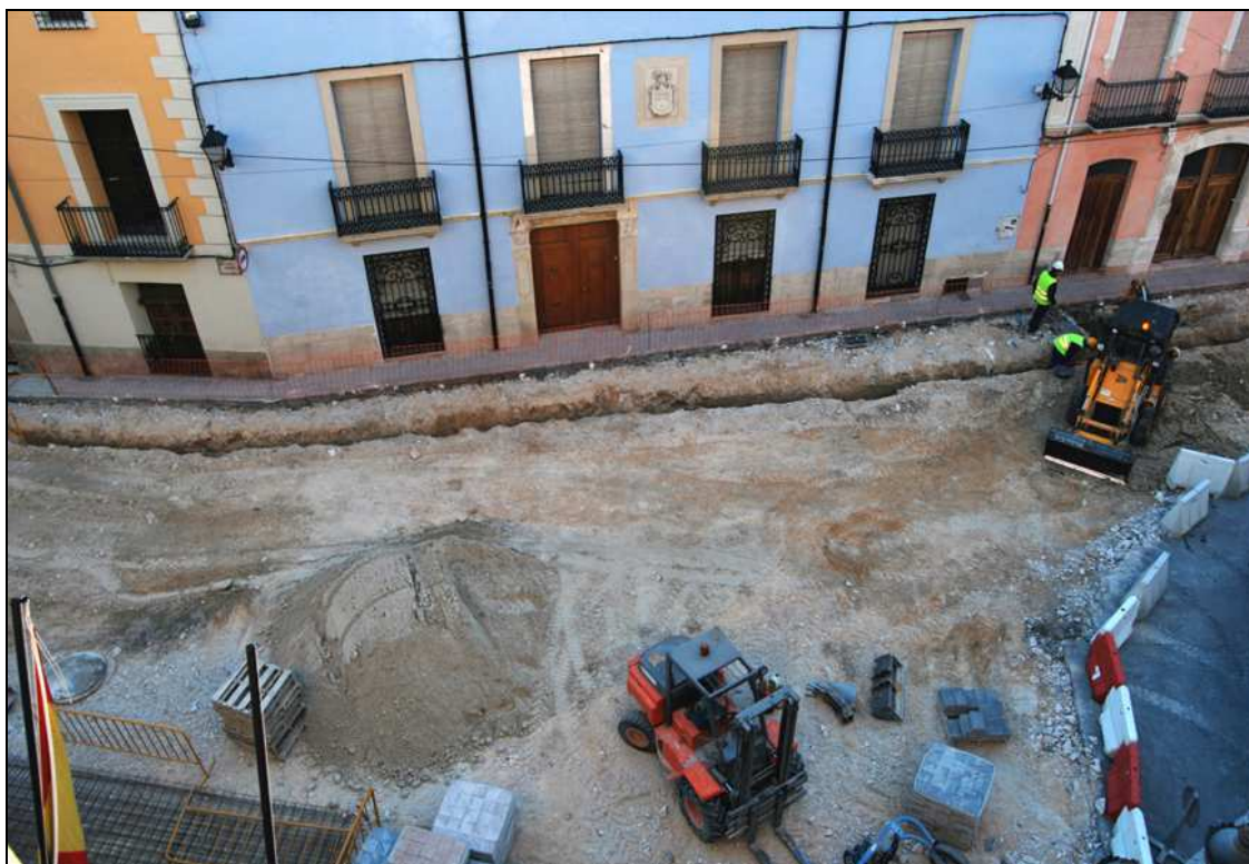
Vista cenital de la zanja de gas abierta en la plaça Major.
