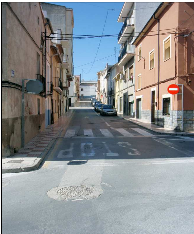
Vista de la calle Ancha antes de las obras.
