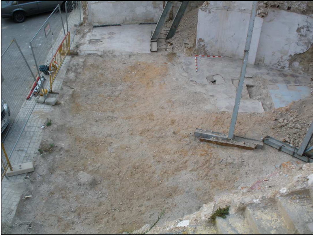
Imagen del solar tras el derribo y antes del inicio de la excavación.
