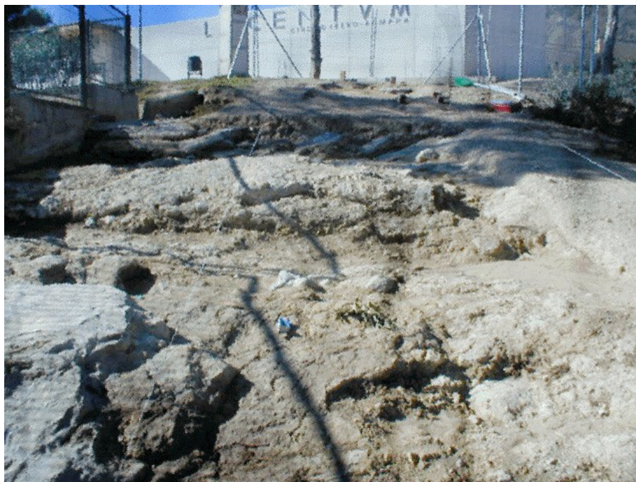
Excavación sector escalera. Tramo superior
