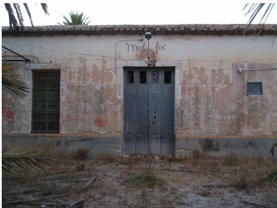
Inmueble Moli Foc (Caserío del Carmen)
