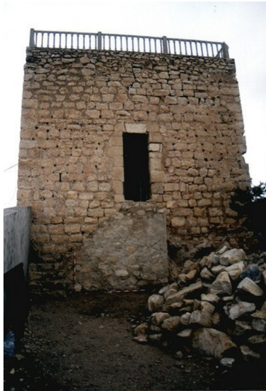
Fachada a levante de la Torre de Aigües, con el ingreso en altura
