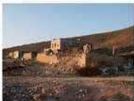
Foto 13: Edificación aneja a P-3
