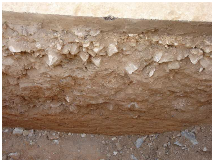
Detalle de la zanja en la calle del Sacramento
