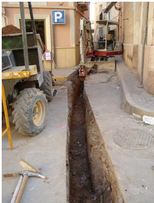
Vista de la zanja en la calle Don Teodoro de Alenda
