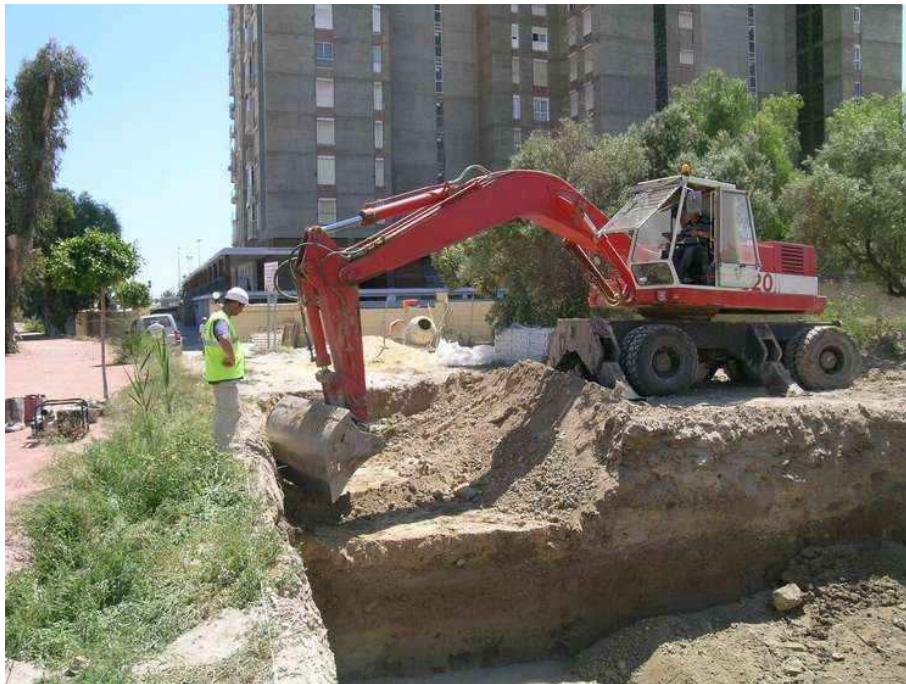
Actuación mecánica Sondeo 2
