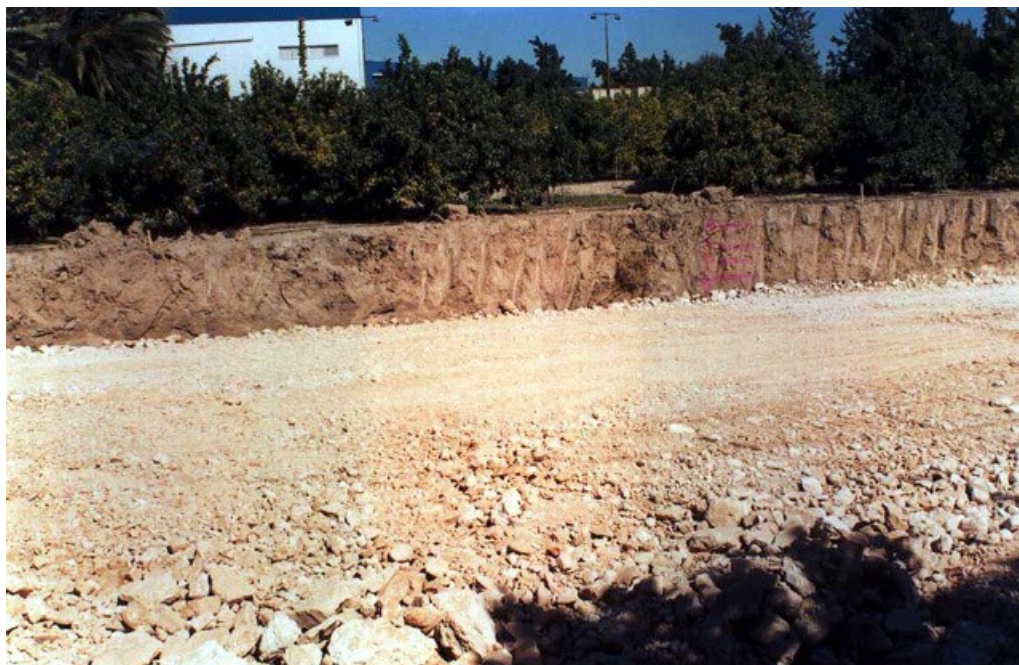
Hacia el NE, tramo en Santa Faz dirección SE hacia la N-332. Preparación del carril
