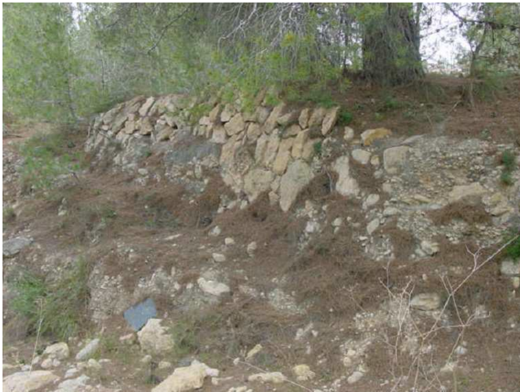
Muros de contención localizados en la prospección
