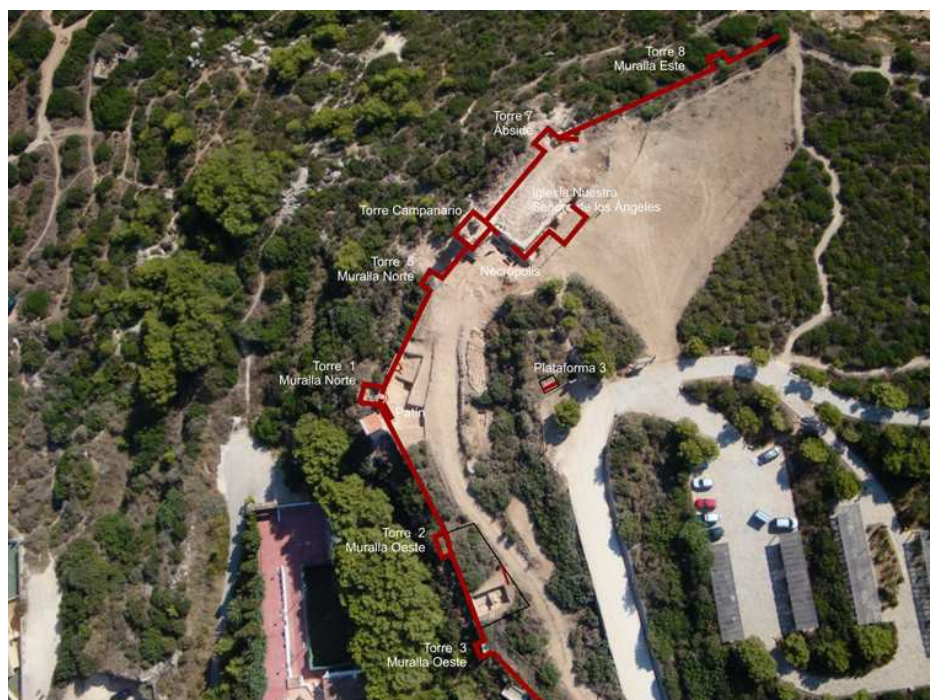
Señalización del área de intervención
