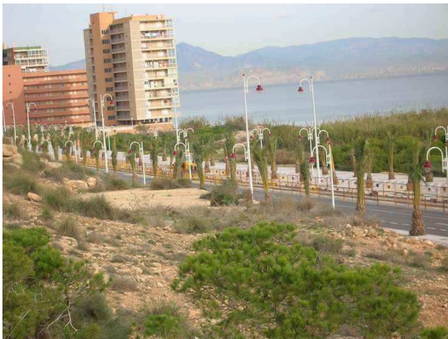
Zanja en una de las avenidas de Arenales del Sol
