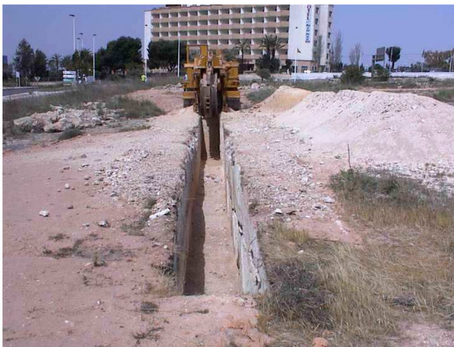
Zanja en la proximidades de Santa Pola
