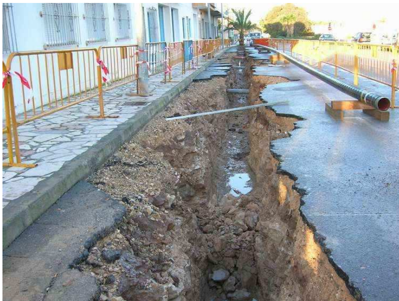
Zanja en una de las calles de El Altet
