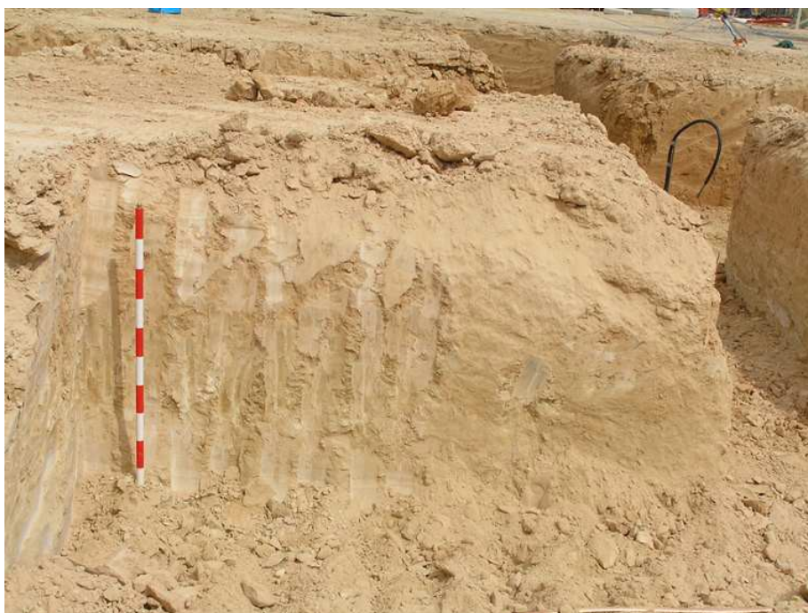
Nivel estéril de las zapatas
