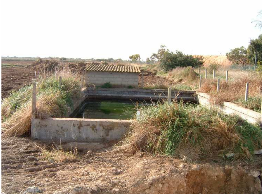
Balsa de riego del Sector IV
