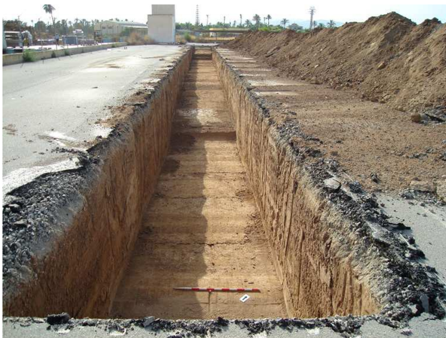
Vista general del Sondeo 2
