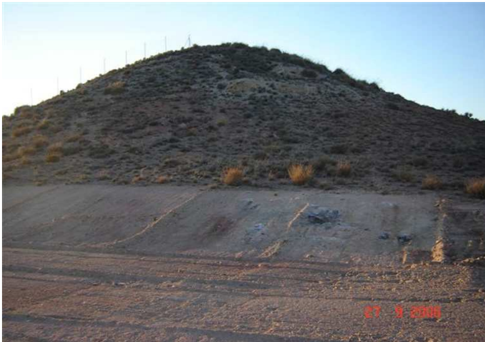
Vista parcial del área de intervención
