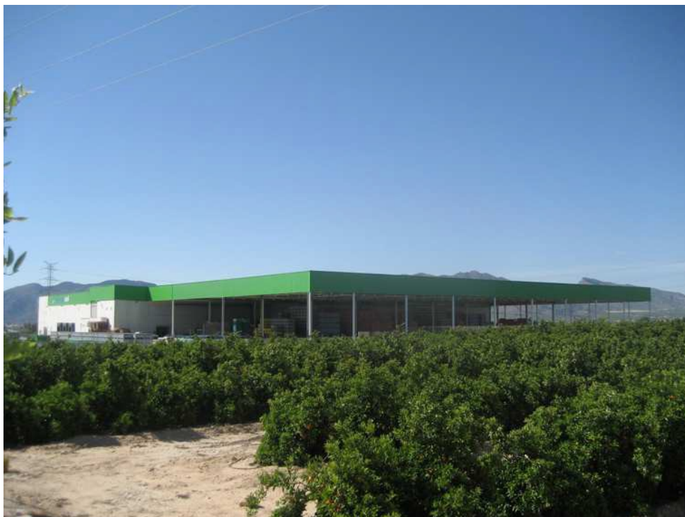
Vista de la nave industrial
