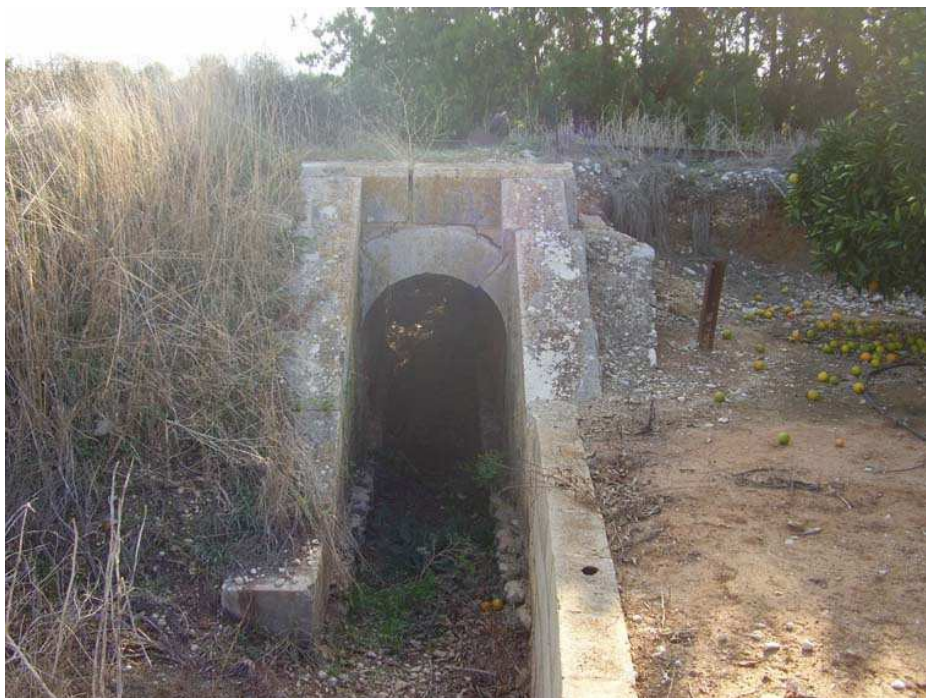
Estructura del ferrocarril de Carcaixent-Denia
