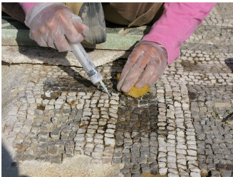
Consolidación de los estratos internos del mosaico opus tessellatum de la zona termal mediante morteros de inyección
