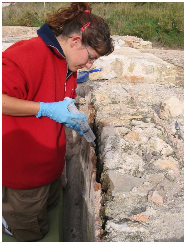
Tratamiento de consolidación de revestimientos en opus signinum
