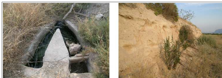
Sistema de canalización entre terrazas y límite oriental de la balsa
