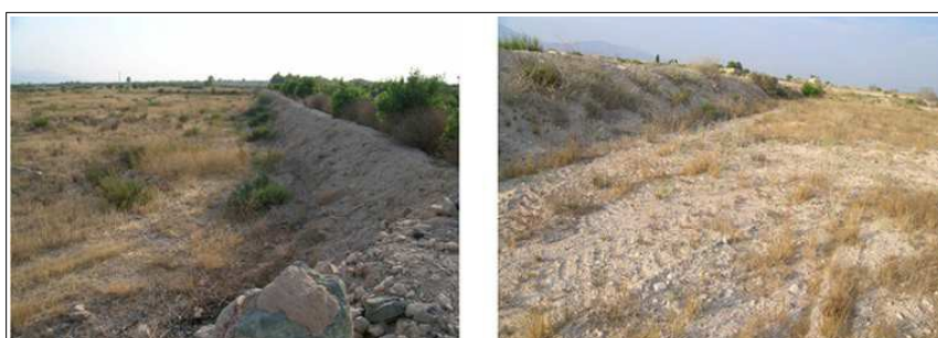
Talud de la terraza del límite norte y detalle
