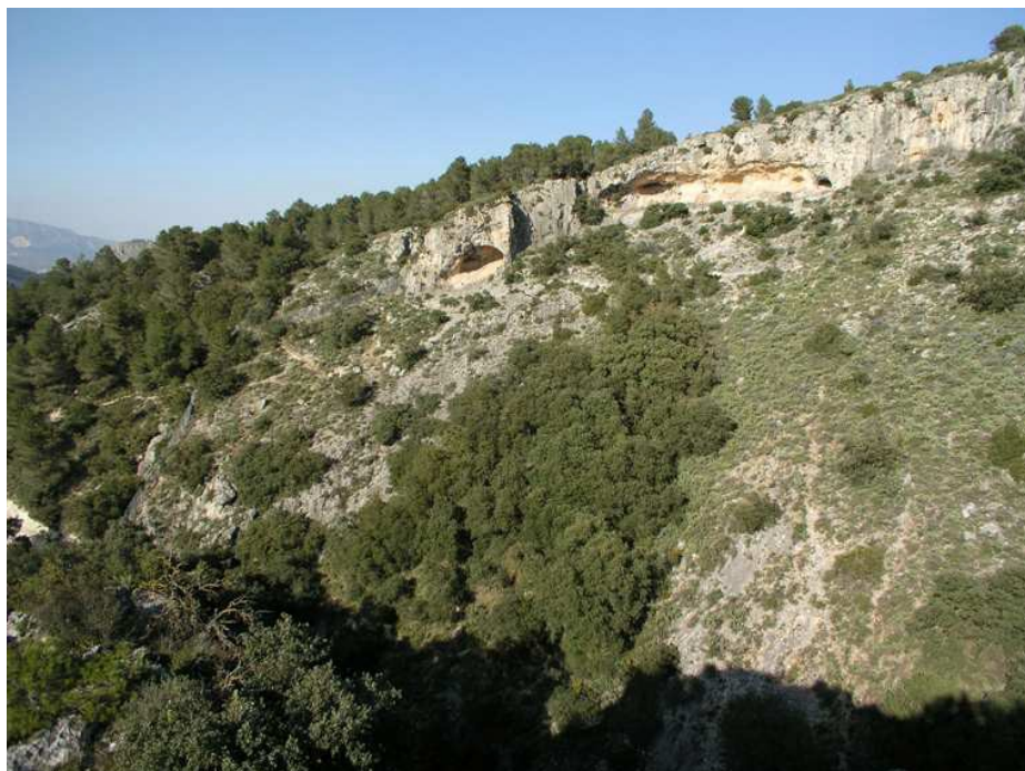
Vista de conjunto del nuevo cerramiento sobre la ladera del barranco
