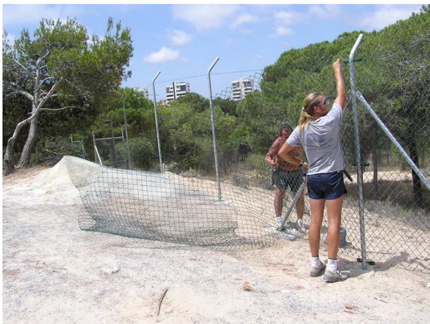
Vista parcial de la valla instalada
