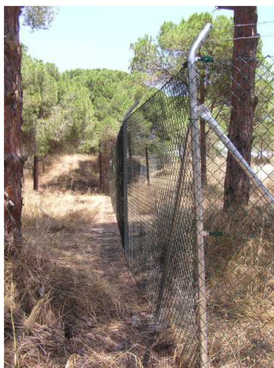
Detalle de la instalación de la valla metálica
