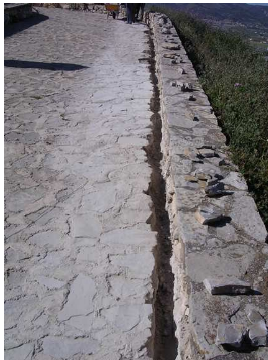
Detalle de la zanja de canalización
