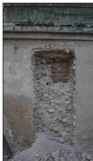
Lámina 5. Vista del sondeo 3, realizado sobre el muro Norte del puente.
