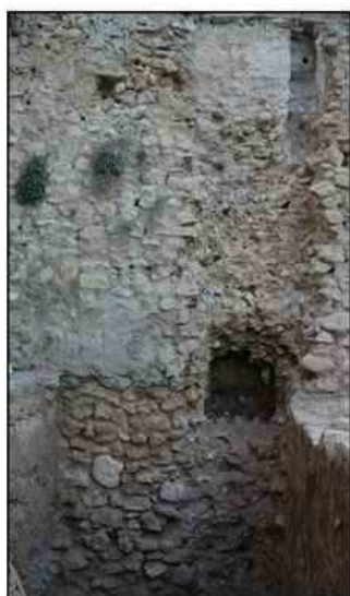
Lámina 3. Vista del sondeo 2, realizado sobre el muro Norte del puente.
