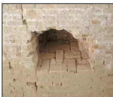
Lámina 4. Vista del sondeo 5, realizado sobre el intradós de la bóveda del puente.
