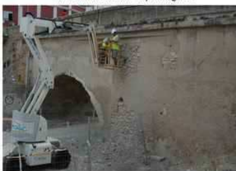
Lámina 2. Realización de catas murarias en la vertiente Norte del puente.
