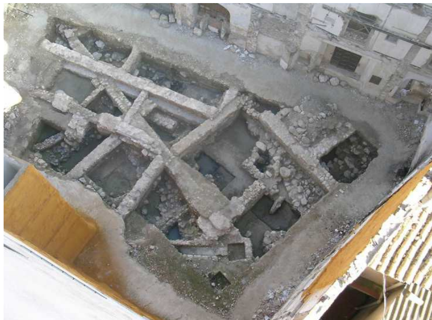
Vista general del solar excavado
