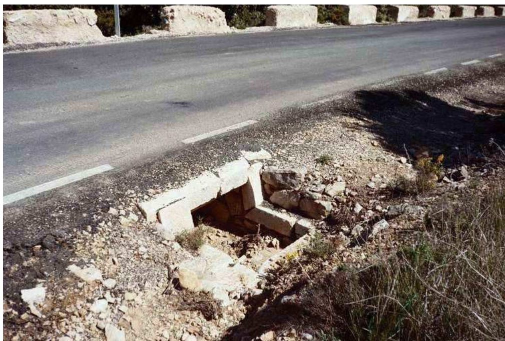
Canalización bajo la carretera
