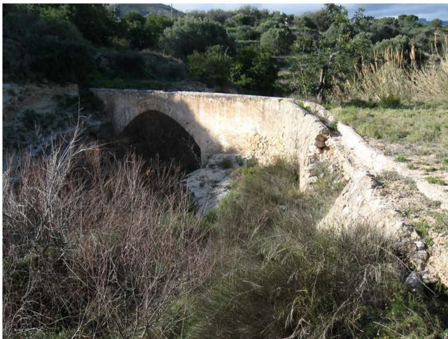
Vista del Pont Benienzo
