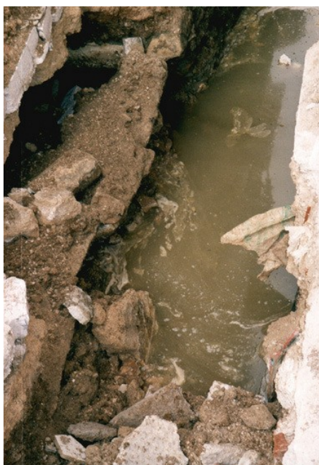
Vista de una zanja
