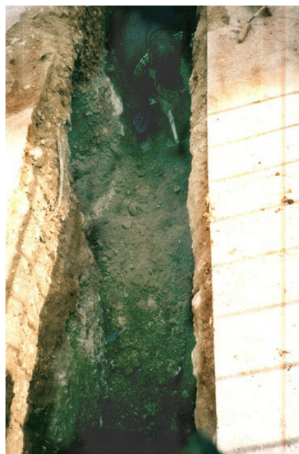
Proceso de excavación de una zanja
