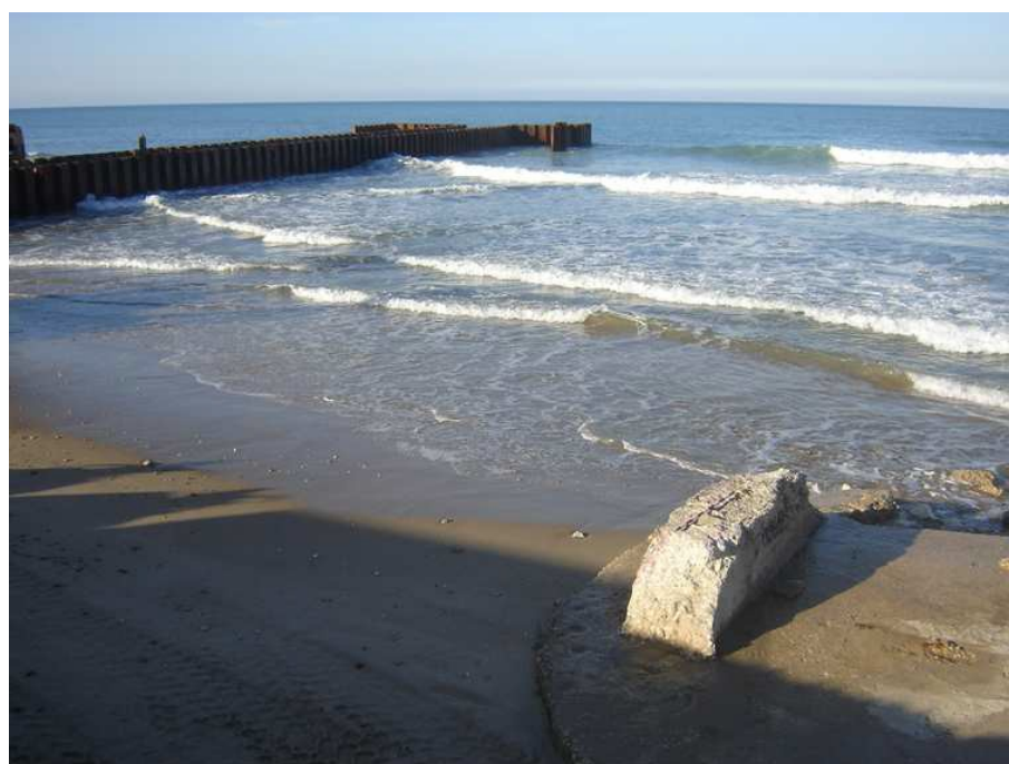
Situación de la posible casamata respecto a la zanja del gasoducto
