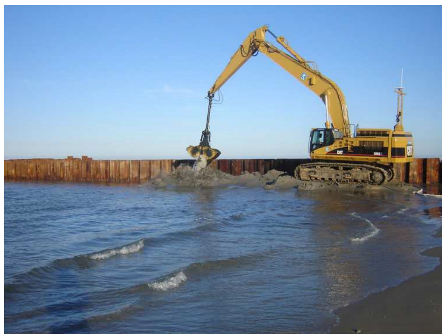
Extracción de áridos para la zanja del gasoducto
