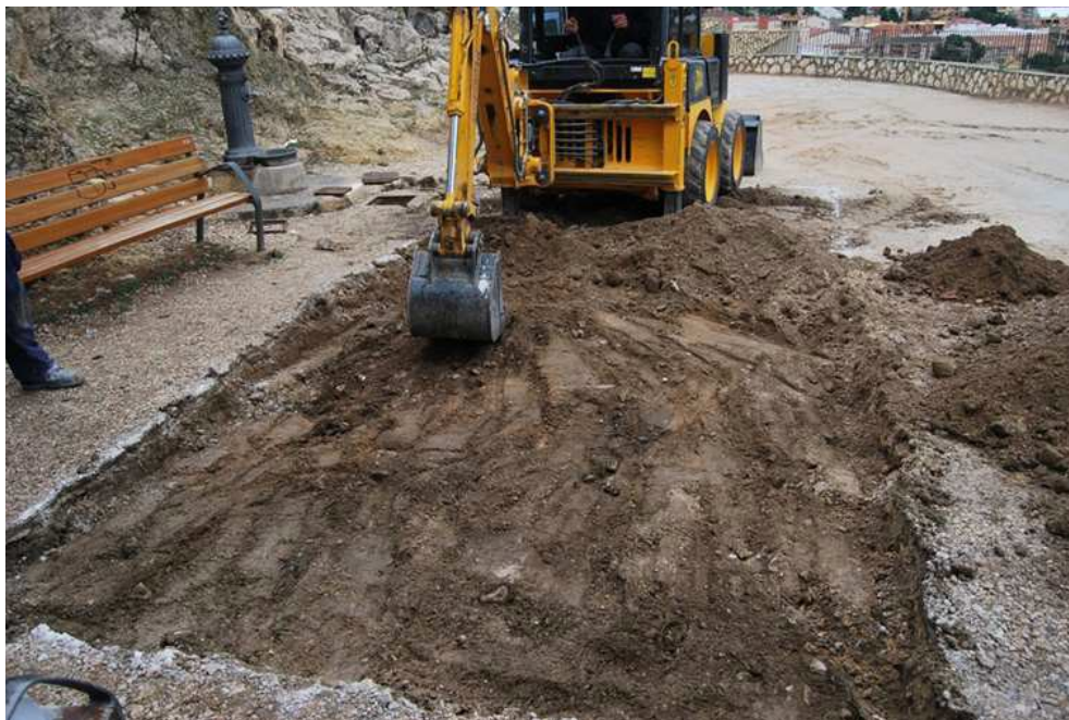
Proceso de excavación de la UE 4: relleno contemporáneo
