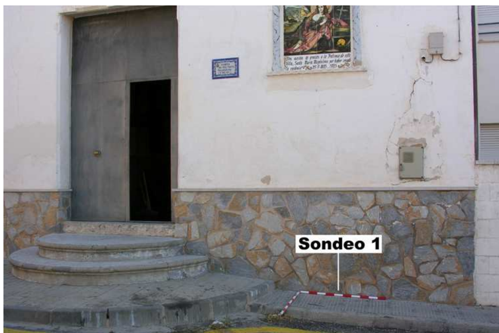
Situación del Sondeo 1
