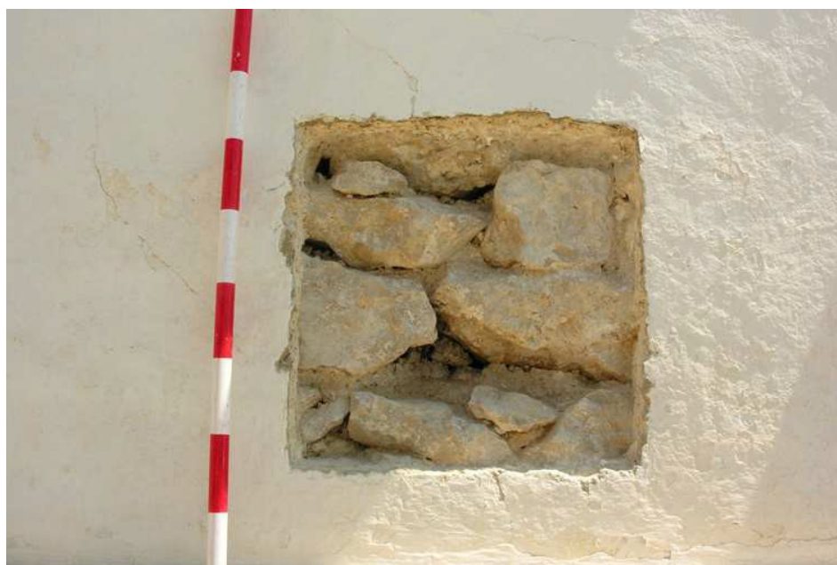
Vista de la fachada original de la ermita en una de las catas murarias
