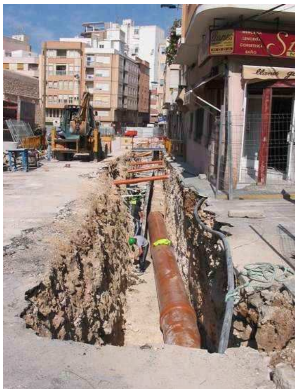
Zanja para la acometida de servicios urbanos
