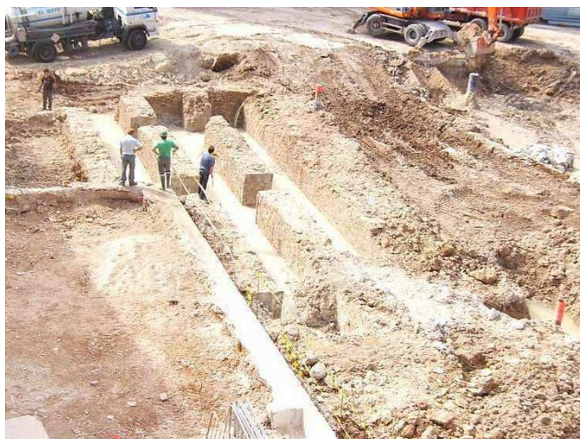
Vista del refugio antiaéreo localizado en el transcurso de la obra
