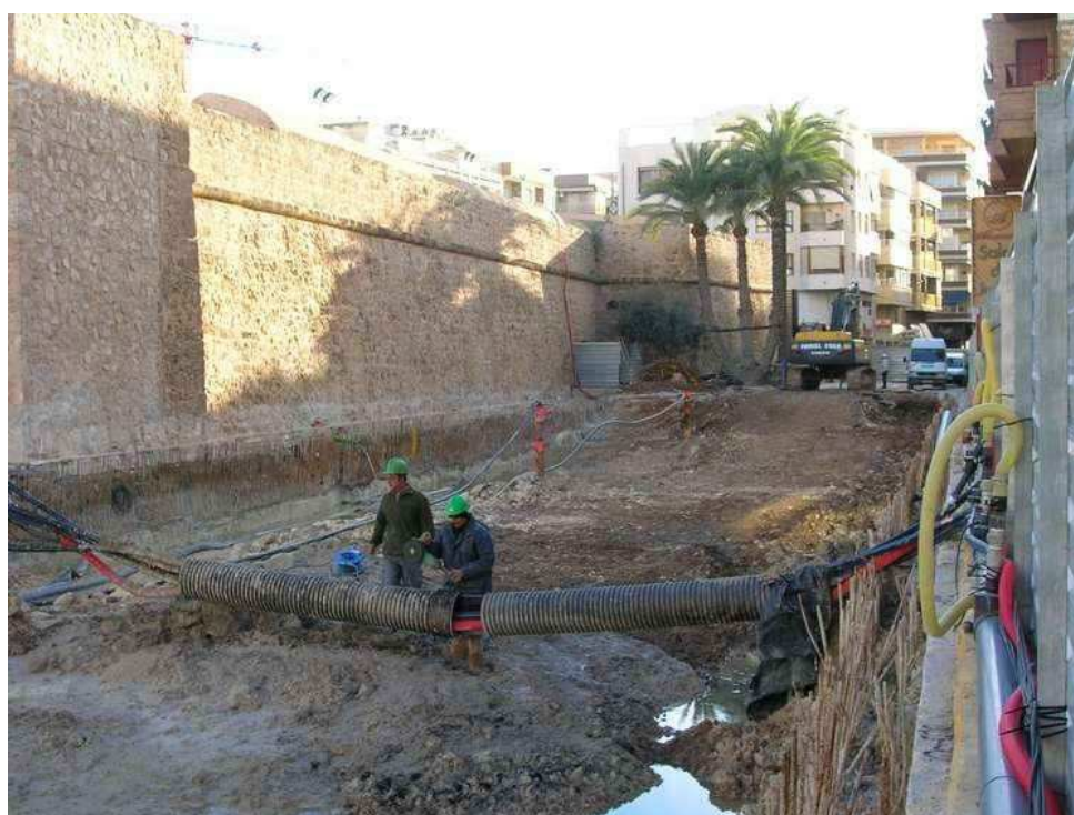
Proceso de rebaje del terreno en la calle Almirante Antequera
