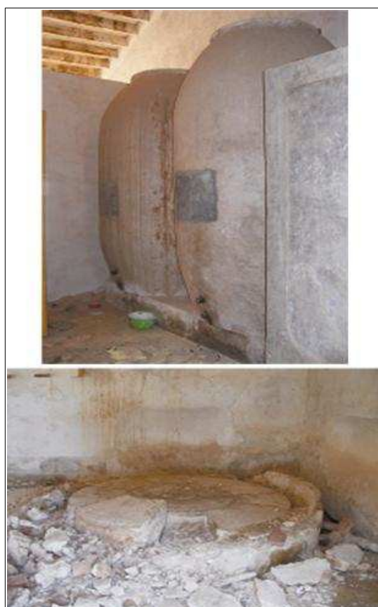
Detalle de la bodega y de la almazara
