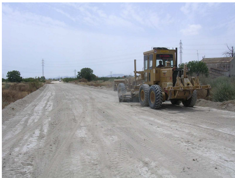
Labores de explanación de la pista
