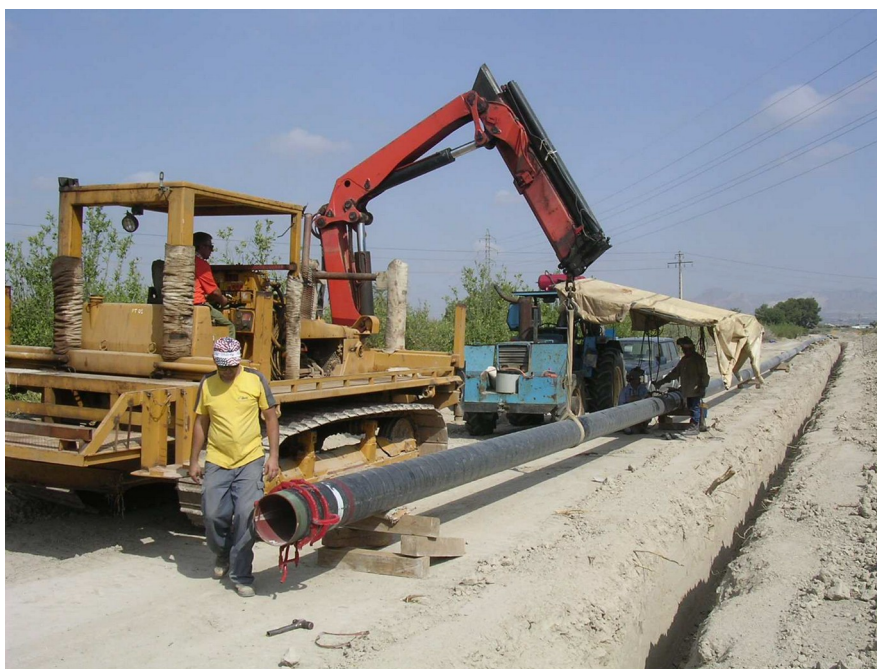
Soldadura de las tuberías previa introducción
