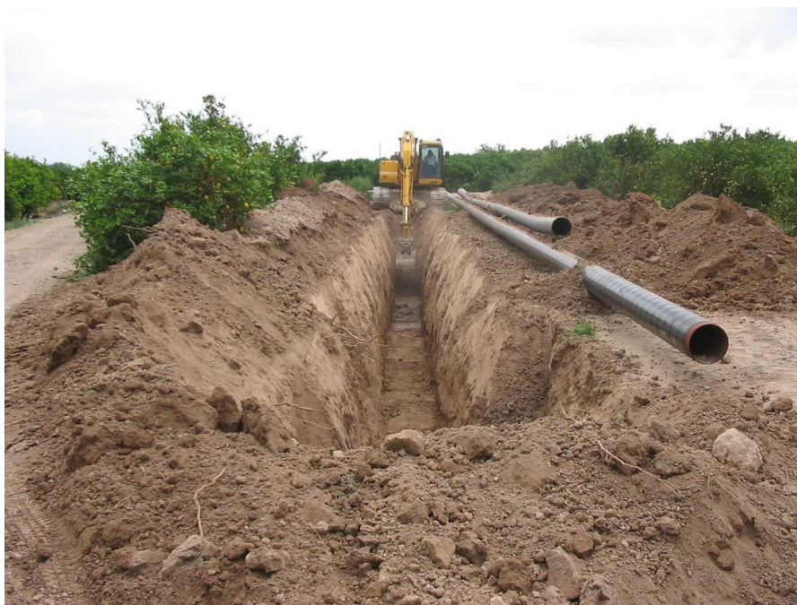
Excavación de zanjas para introducir la tubería
