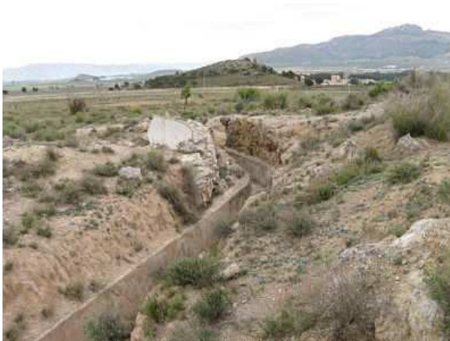
Canal de distribución de agua
