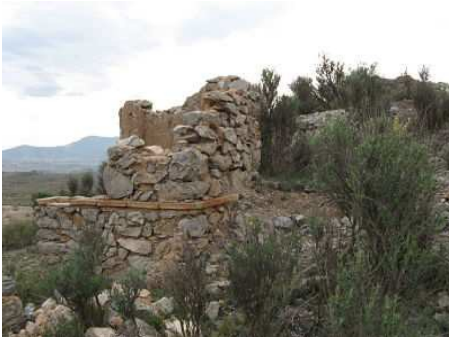
Conjunto constructivo moderno
