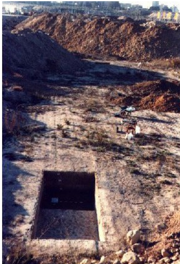
Vista general del solar con una de las catas manuales realizadas
