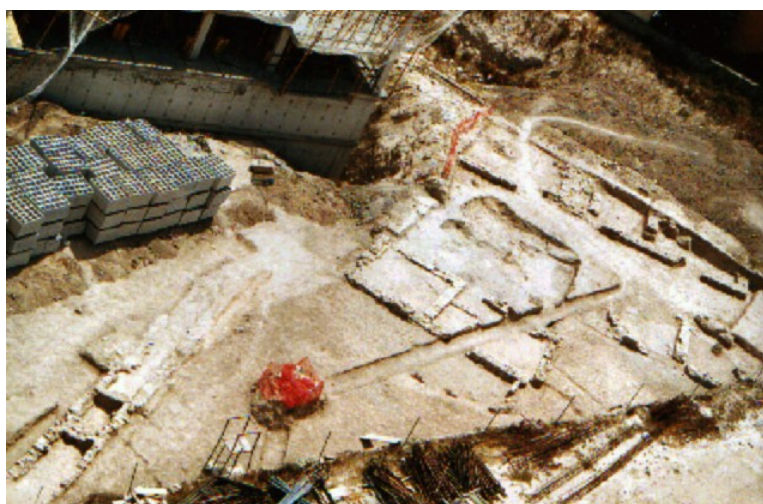
Vista general de la excavación
