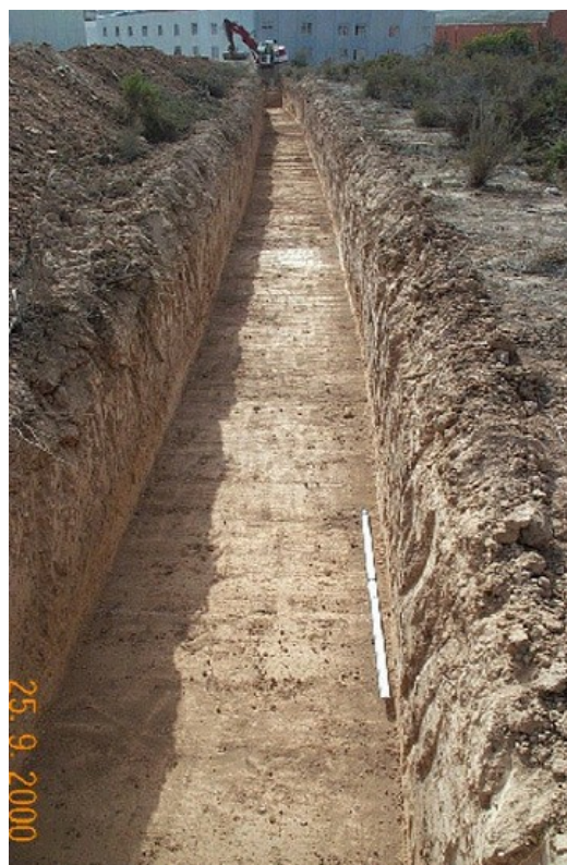
Vista de la zanja 2
