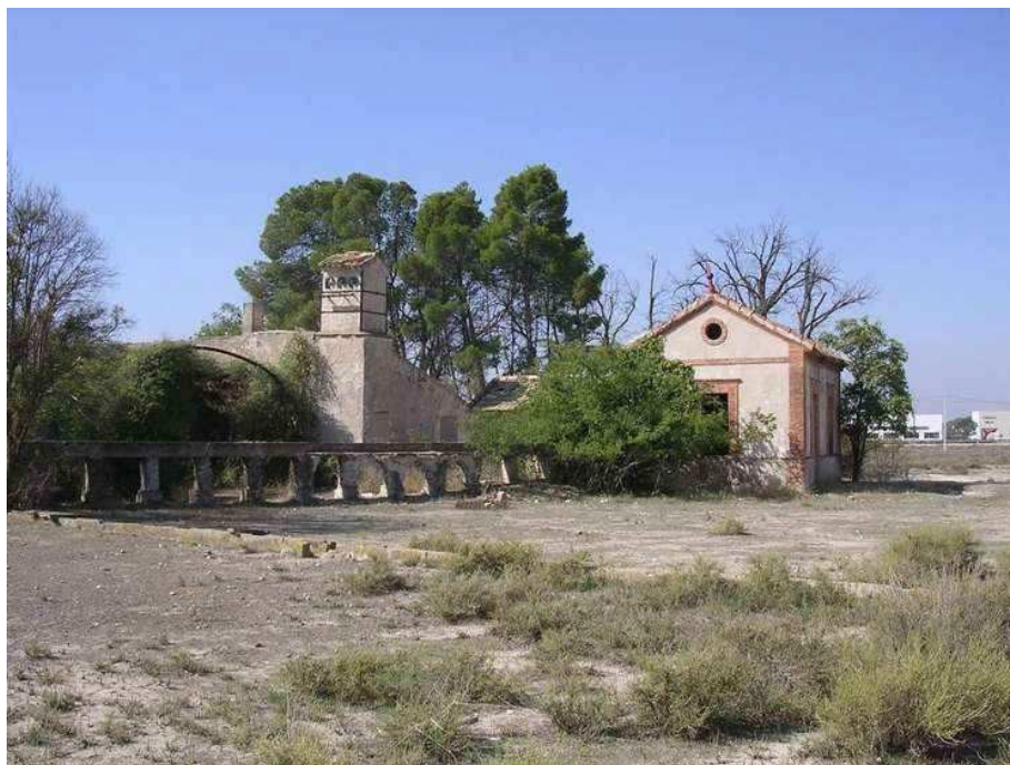
Motor y acequia de riego
