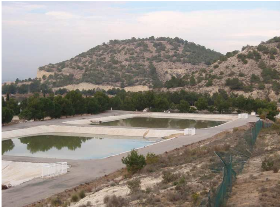
Zona ocupada por la EDAR
