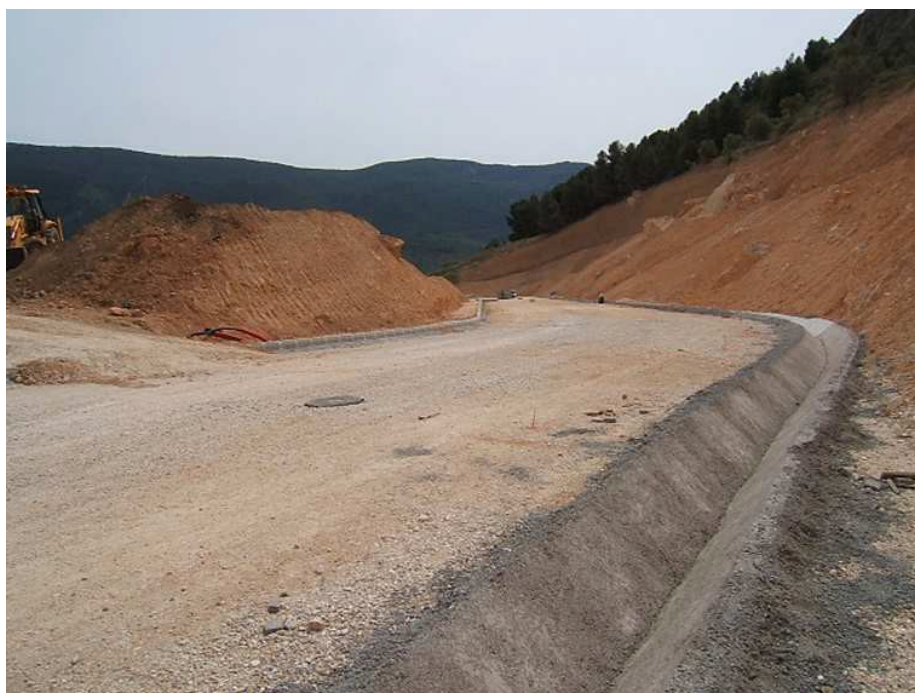
Construcción de viales en la parte baja del Castellar
