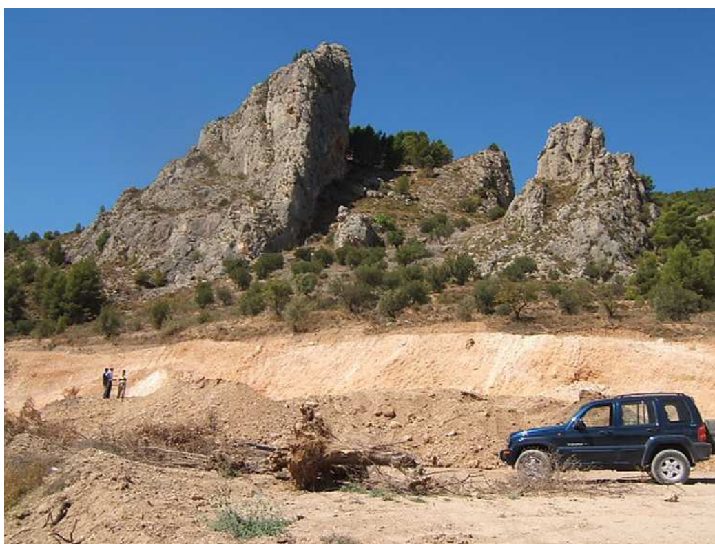
Movimiento de tierras y situación del poblado del Castellar en la montaña
