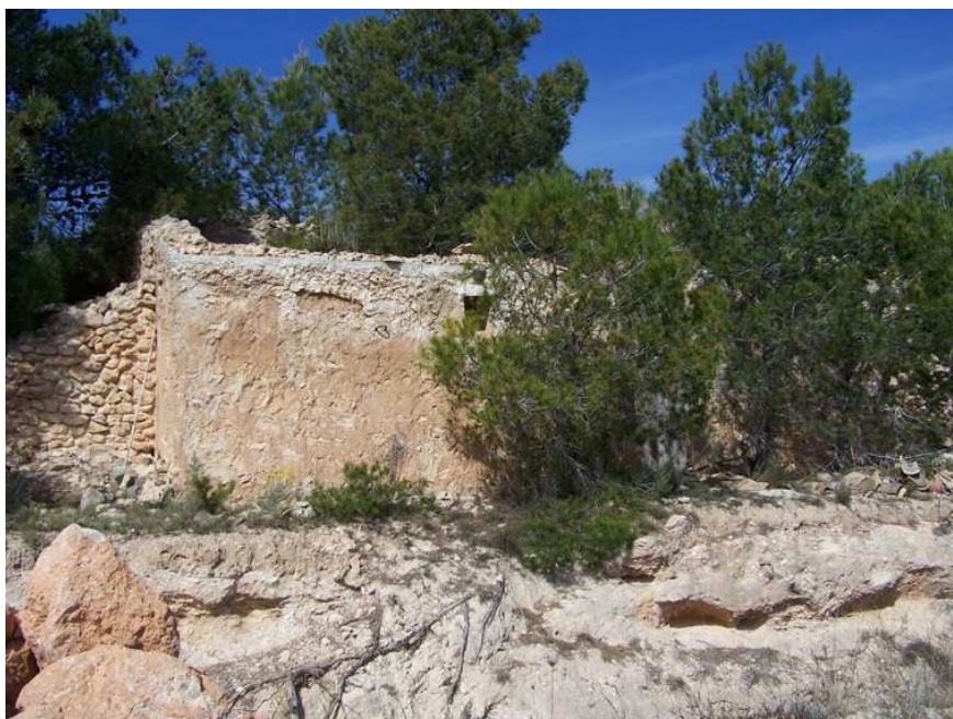
Caseta de maçoneria
